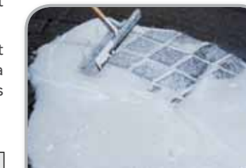
Mettre dans les joints
