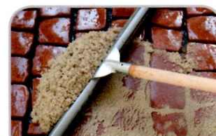
Appliquer à l'aide d'une raclette de caoutchouc
