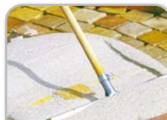
Mettre dans les joints
